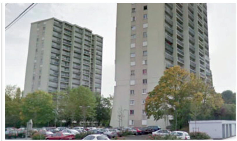
La copropriété résidentielle « Hélène » à Montataire : 228 logements répartis sur deux bâtiments
